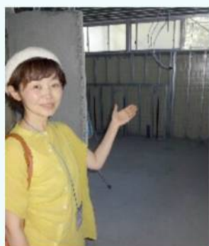
改修工事中のトイレ(神戸小)
