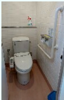
亀山中の学校トイレ
