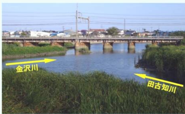
金沢川下流 近鉄鉄道橋付近
