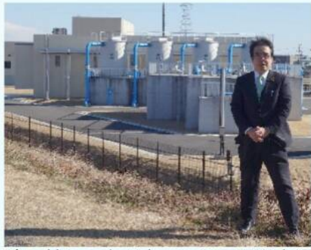
建て替え工事が完了した平野送水場
