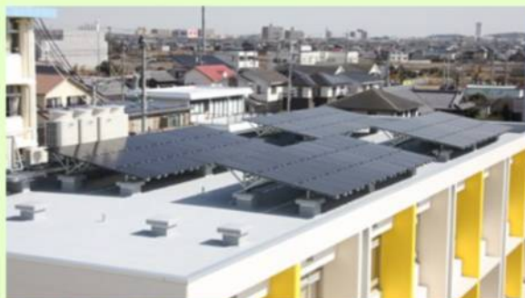
稲生小学校屋上の太陽光パネル(鈴鹿市HPより)
