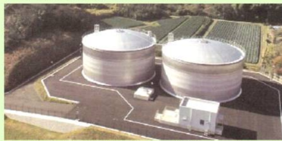
新設された国府第二配水池 (パンフレットより)
