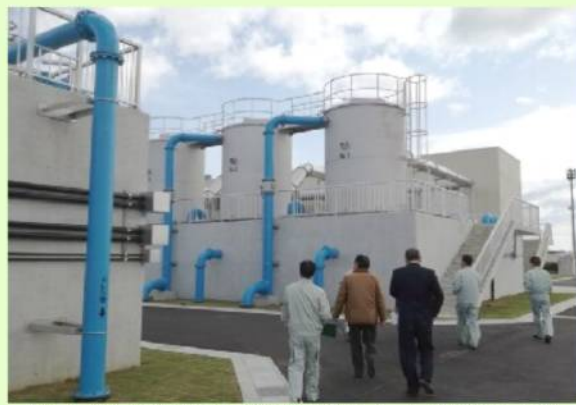
築46年が経過し建て替えられた平野送水場
